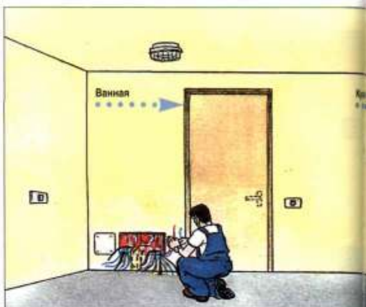
2. Первая операция соединения кабелей в ответвительной коробке
