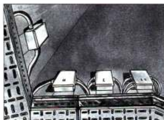
12. Пример соединения собранных на лотке (или площадке) ответвительных коробок
