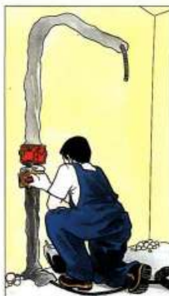
6. Заделывать канавки цементным раствором
