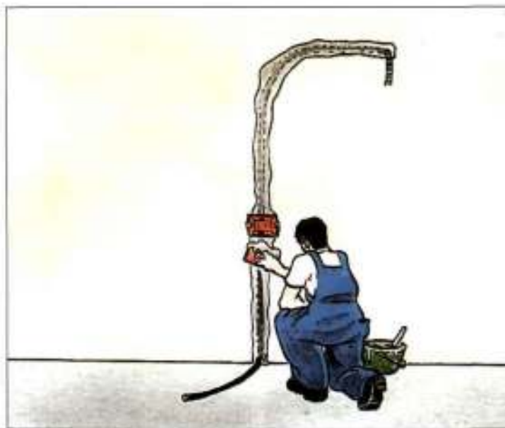
2. Заделывание канавки цементным раствором
