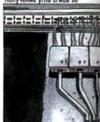
11. Пример спуска кабельных труб от ответвительных коробок (уменьшение бокового габарита)
