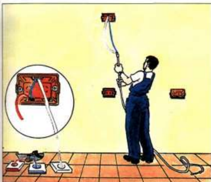
4. Протяжка кабелей при помощи троса до точки установки звонка
