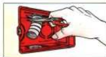
8. Перерезать трубы заподлицо коробки
