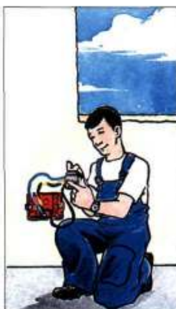
6. Подключение кабелей к штепсельным розеткам 10 А
