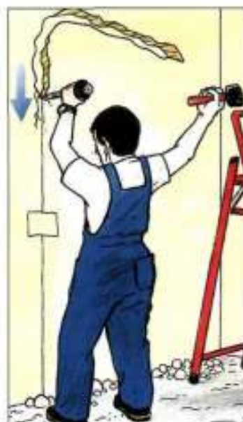
3. Выполнить канавки в стене
