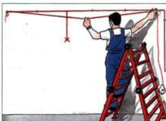
2. Разметить на стене трассу кабельных труб при помощи соответствующей нити
