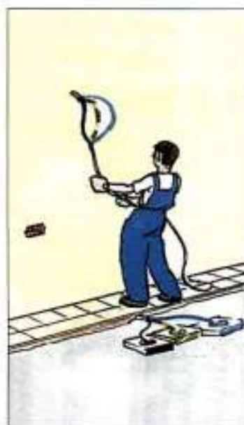
9. Осуществлять протяжку кабелей при помощи соответствующего троса
