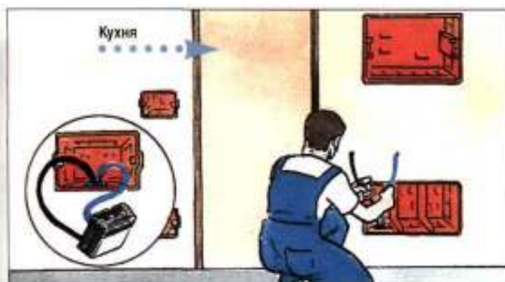
4. Протяжка кабелей для соединения приборов аварийного освещения
