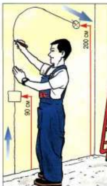
2. Выполнить разметку канавок на стене
